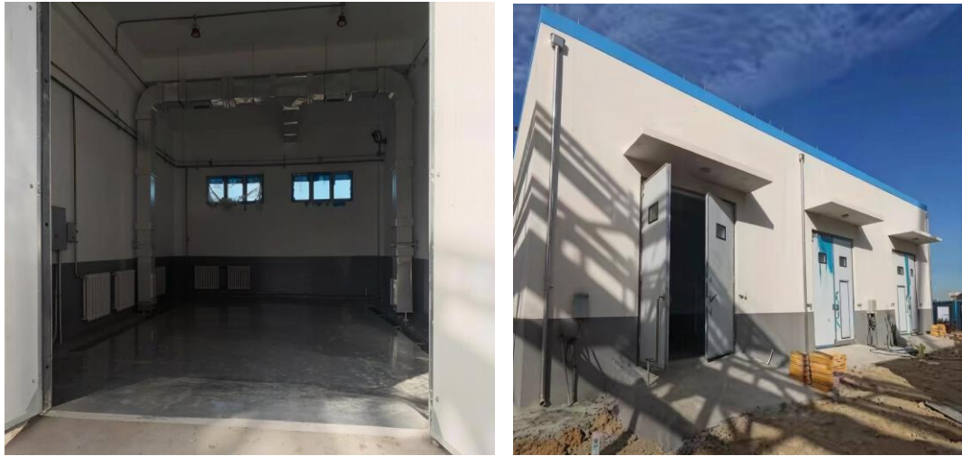
图 2-4 危废暂存库现状情况
