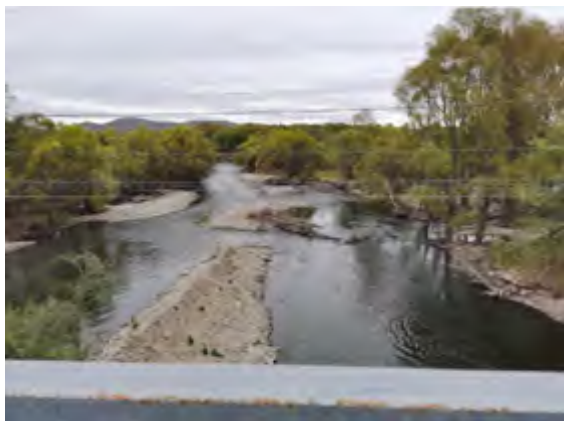
K246+168 洮儿河 9 号桥现场照片
