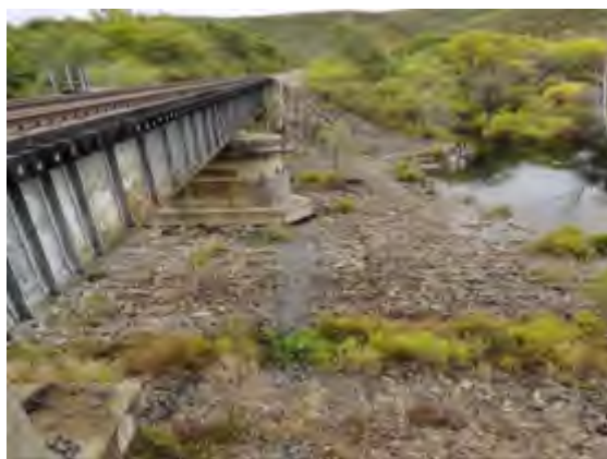
K246+667 洮儿河 8 号桥现场照片
