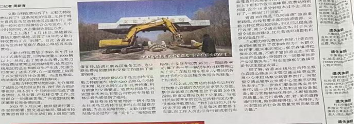
兴安盟高速公路收费站拆除工作正在有序进行。
